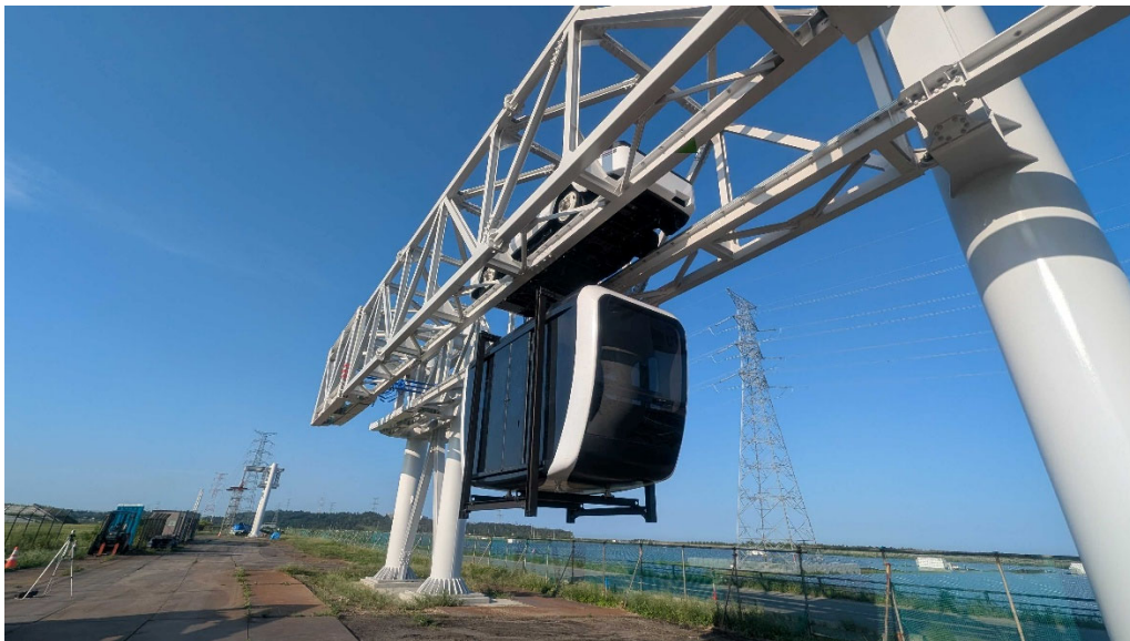
福島試験線にて Zippar 車両走行の様子 (Zip Infrastructure より提供)
